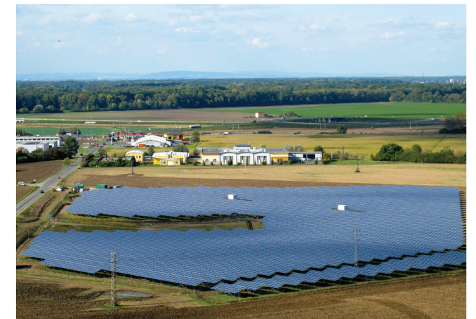
Fotovoltaická elektrárna v Bílaněch u Kroměříže má instalovaný výkon: 4,5 MW, celková investice 360 mil. Kč
