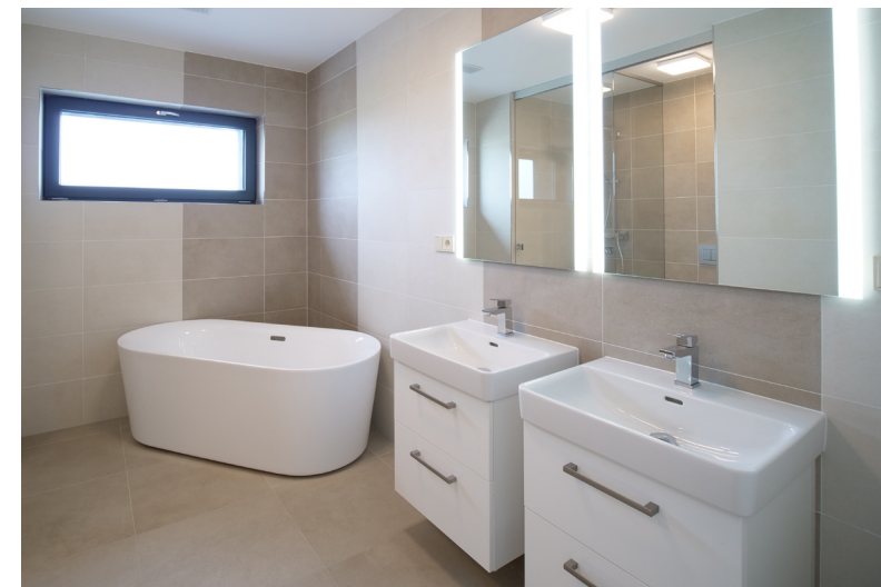
Provádíme montáž rozvodů vody a kanalizace a instalaci zařízení a předmětů
